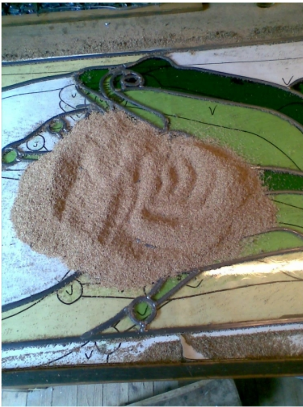
Glas in lood: houtstof komt vrij bij het verwijderen van kit met behulp van zaagsel
